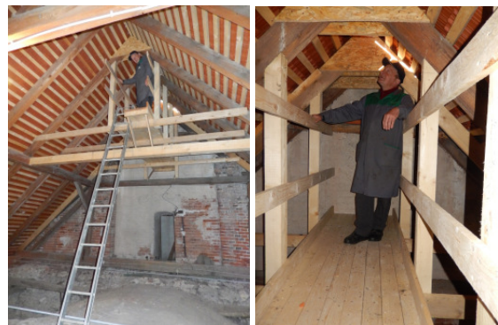
Plattform mit Leiter im Dachboden der Kirche Lackendorf (linkes Bild), Herr Sorko auf der Plattform direkt unter dem Zuflugschlitz (auf den Brettern am Boden sind Kotpillen der Fledermäuse zu sehen).
