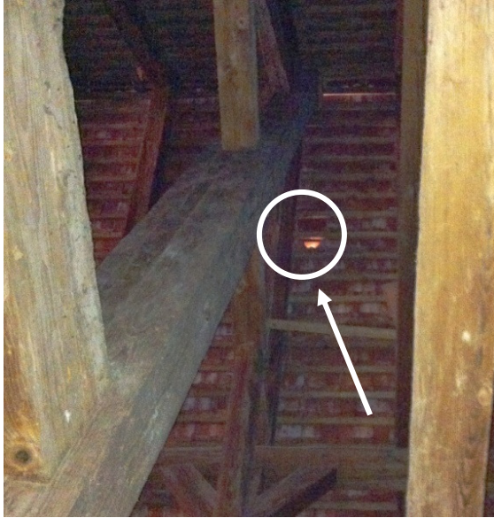
Öffnung des Lüftriegels von innen gesehen. Foto M. Dobrovits
