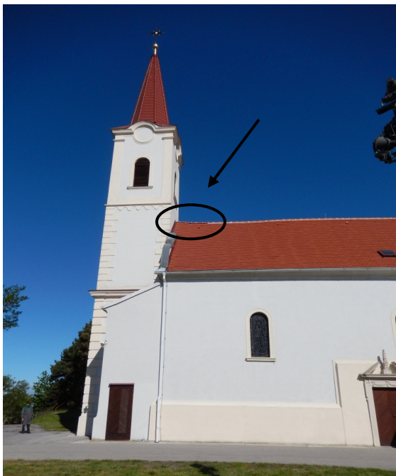
Kirche Lackendorf: der unverputzte Schlitz befindet sich am First links vom Turm.
