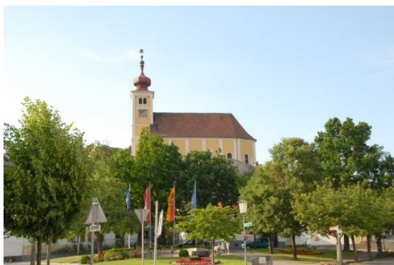
Bergkirche vor der Renovierung
