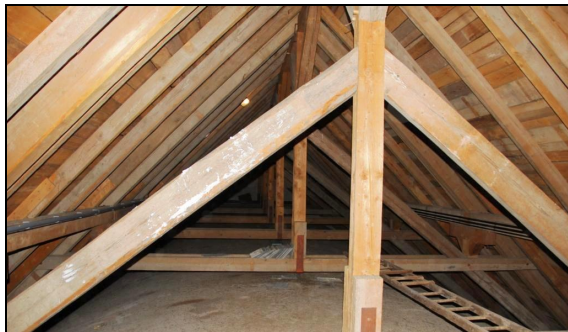
Vollschalung mit Eternitdeckung in der Kirche Lackenbach
